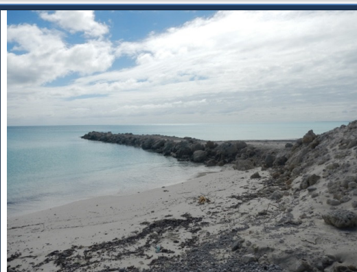
Site de chargement temporaire
